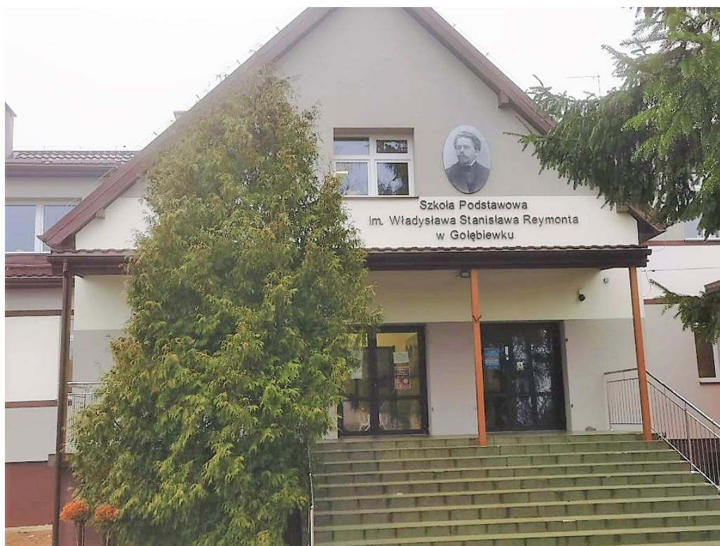
Fotografia 5 Szkoła Podstawowa w Gołębiewku
